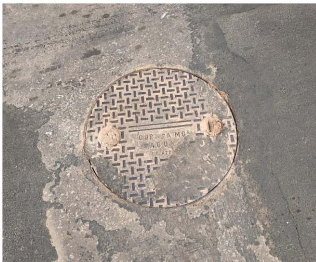
Foto 23 – Poço de visita localizado na Rua do Brejo
