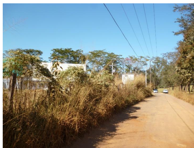
Foto 22 – Posteamto em área consolidada em frente ao terreno
