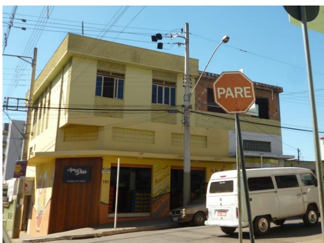
Foto 5 - Edificação de uso misto - comercial e residencial Foto: UMA GESTÃO DE PROJETOS, 2019
