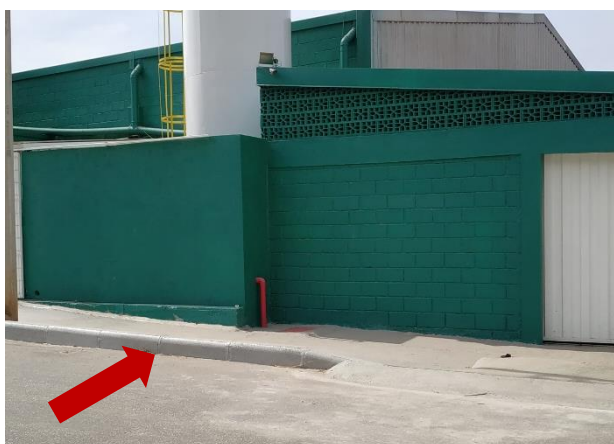
Foto 26 – Vista sarjeta na vizinhança potencialmente afetada Fonte: UMA GESTÃO DE PROJETOS, 2019
