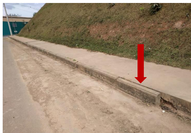
Foto 27 – Vista de sarjeta na vizinhança potencialmente afetada Fonte: UMA GESTÃO DE PROJETOS, 2019
